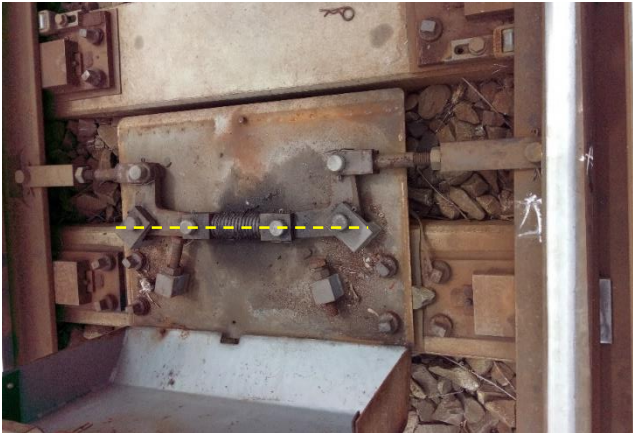
Фиг. 2. Пружинна кобилица на стрелка №20, установена в нерегулирано (равновесно) положение
