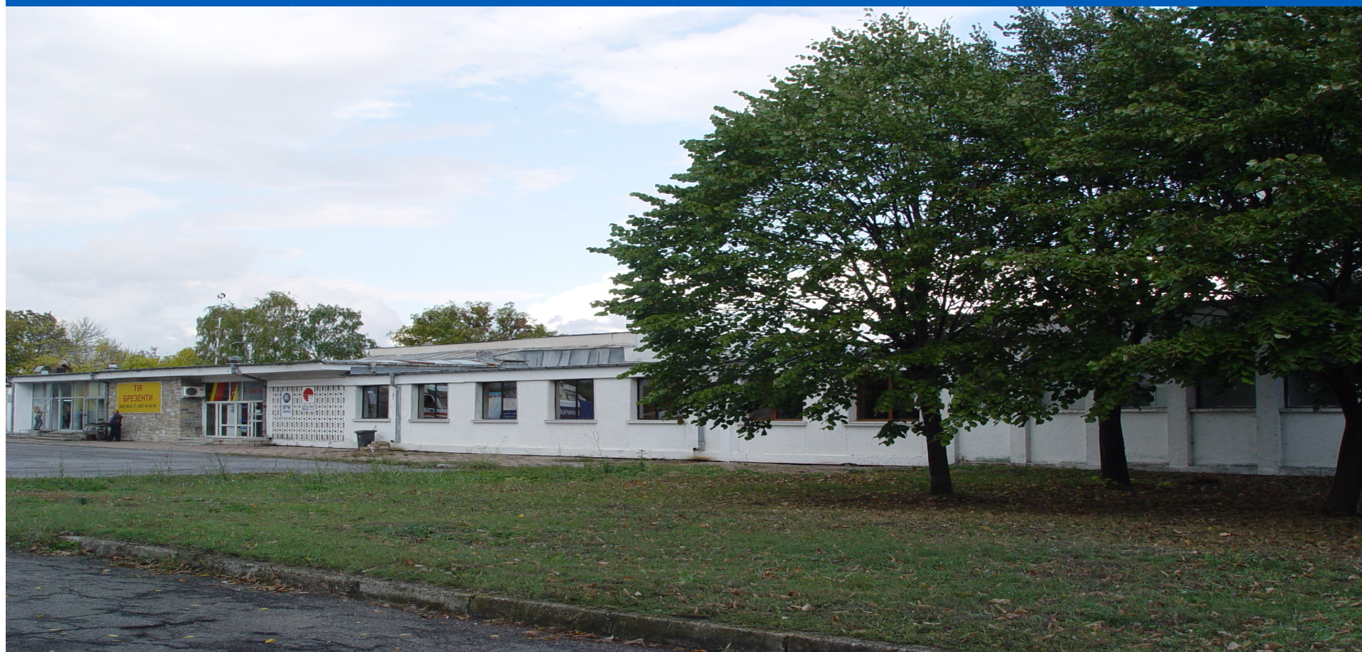
изглед запад на административна част и приемна сграда
