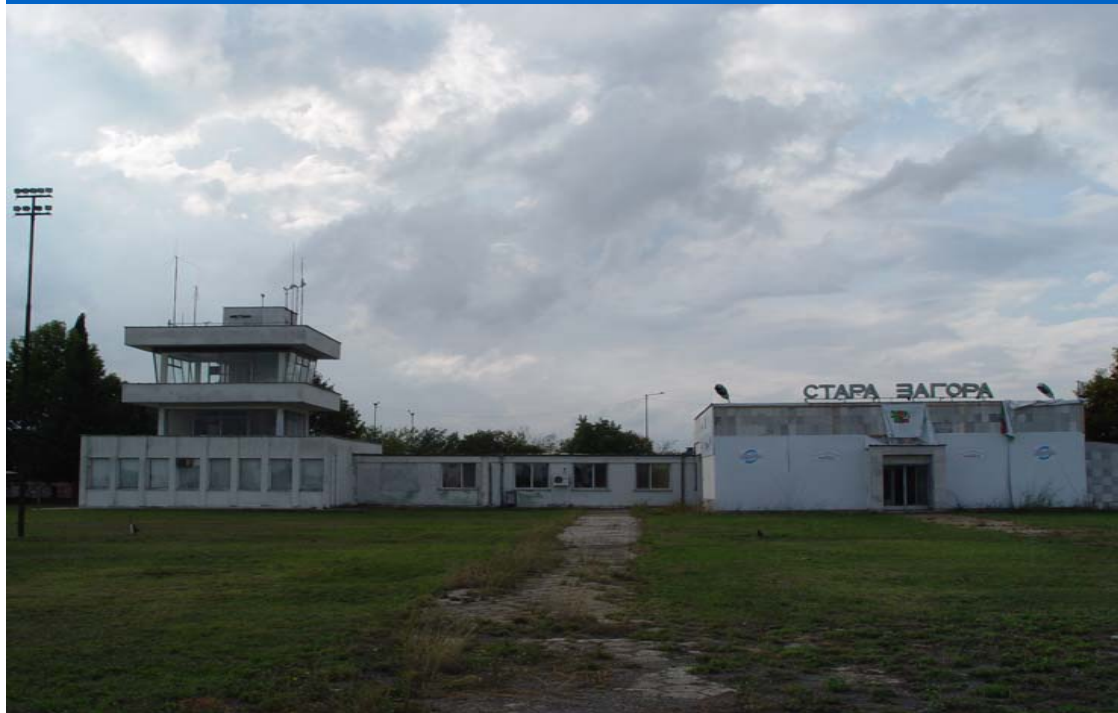
изглед изток на приемна сграда и технически блок „РВД”
