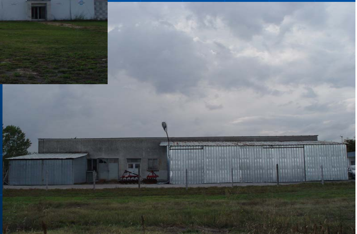
изглед изток на складови помещения и автостопанство
