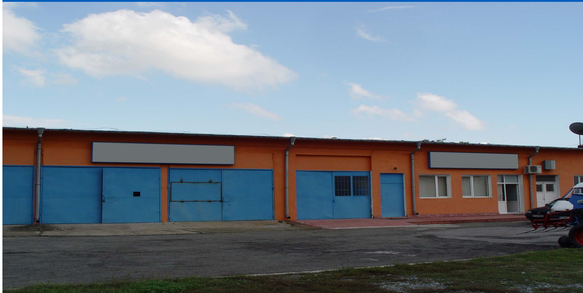
изглед запад на техническа сграда
