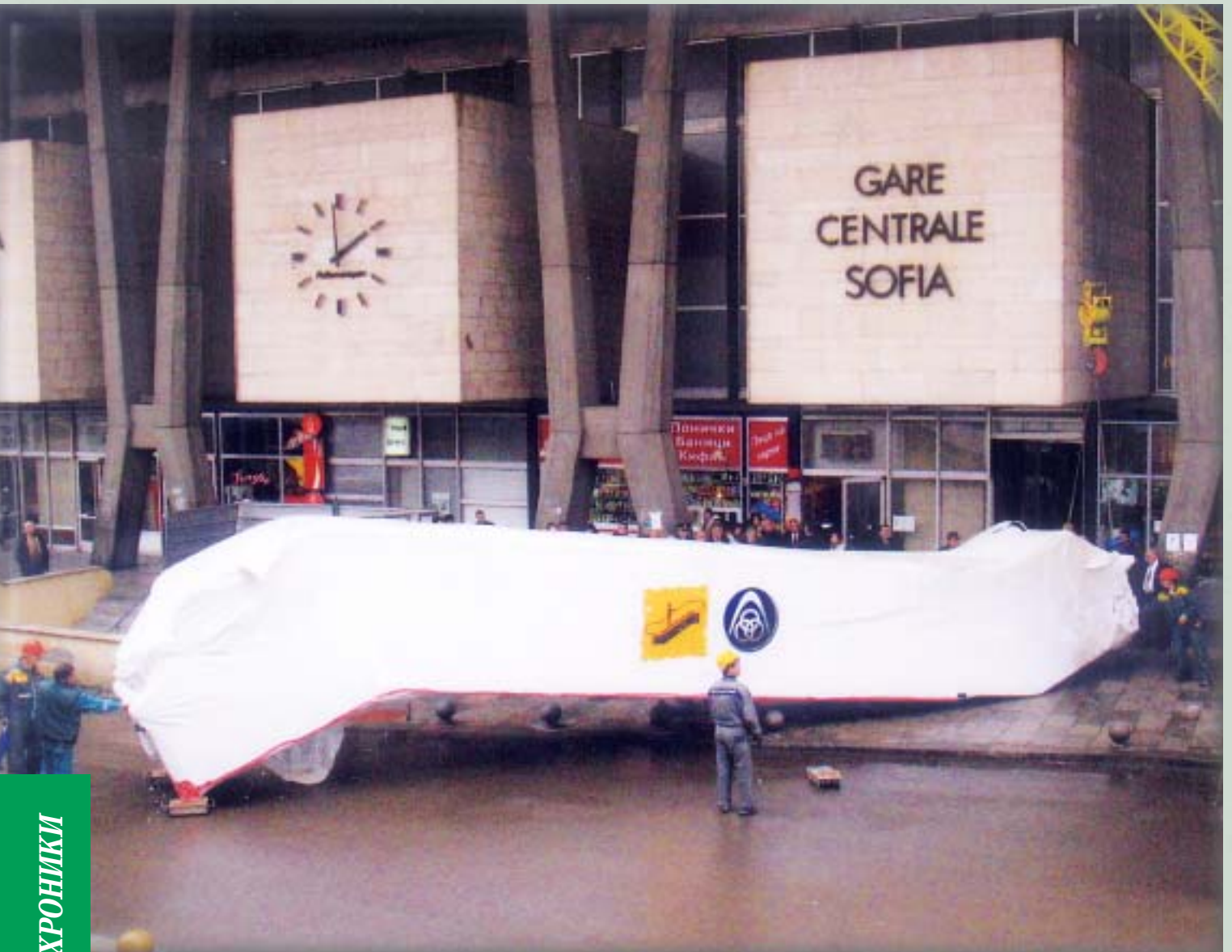
Обновяване на Централна гара - София. Монтиране на нови ескалатори
